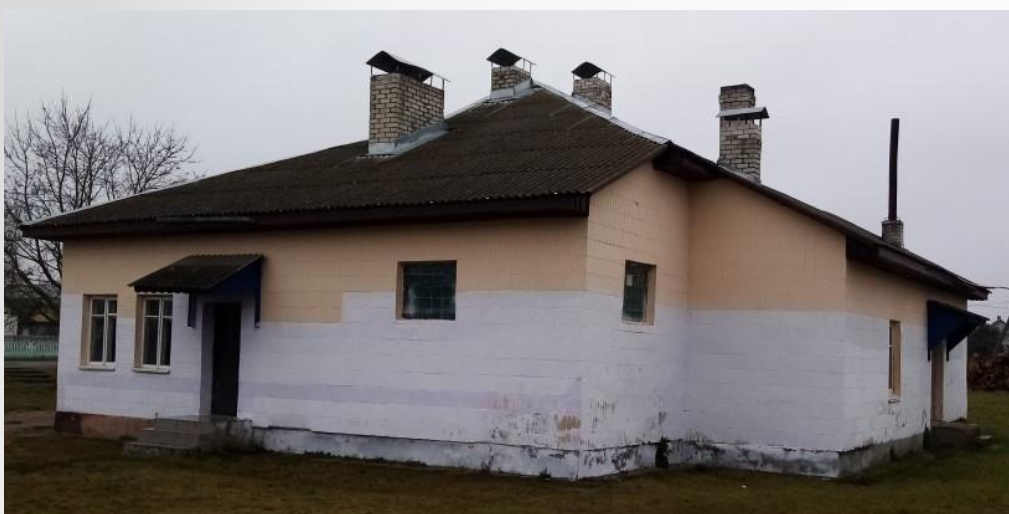
Здание бани с составными частями
