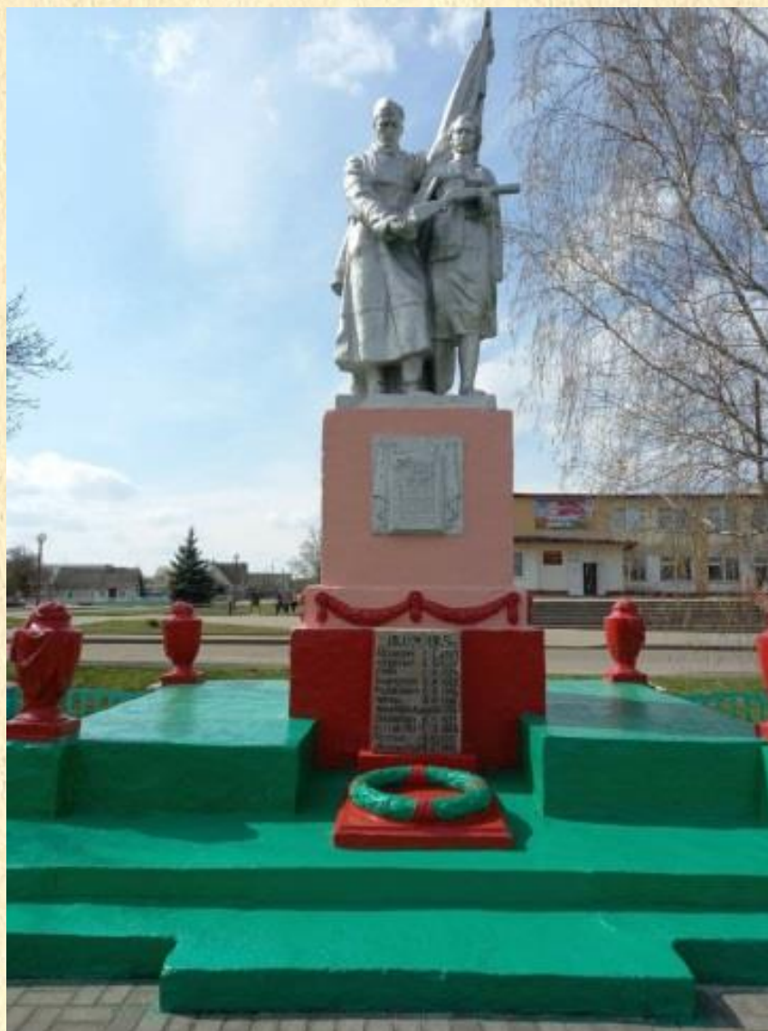
Памятный знак до реконструкции
