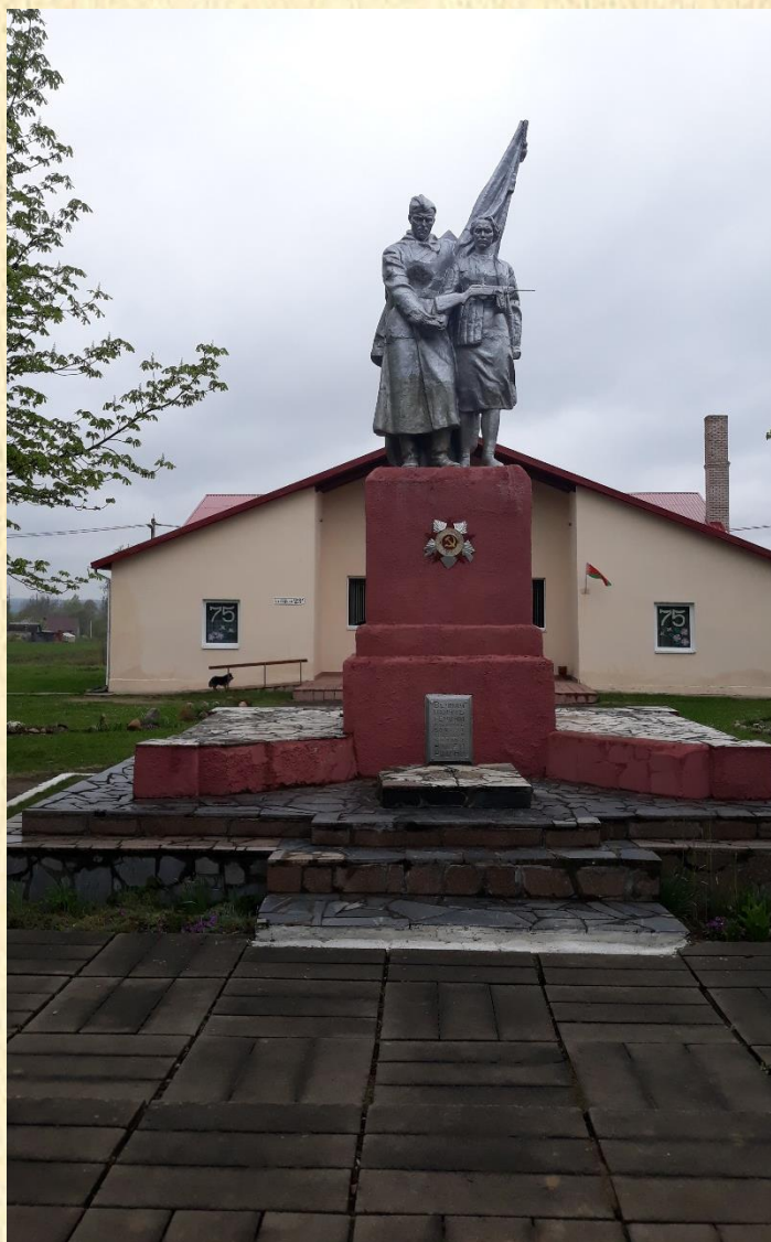
Памятный знак до реконструкции
